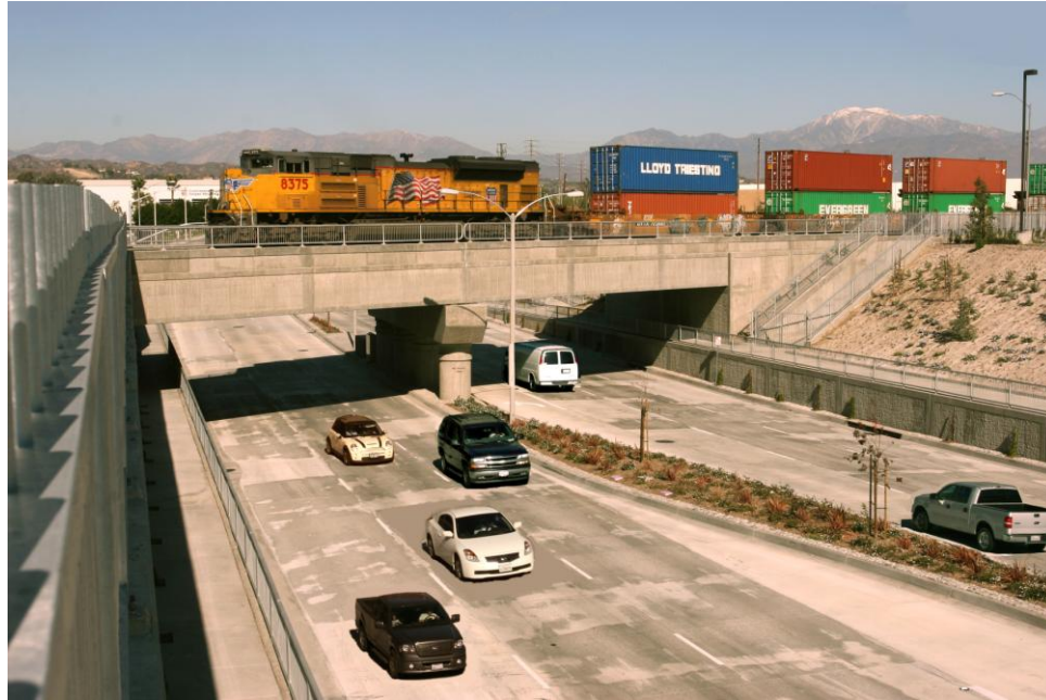
Brea Canyon Road 鐵道平交道 分隔工程實景
