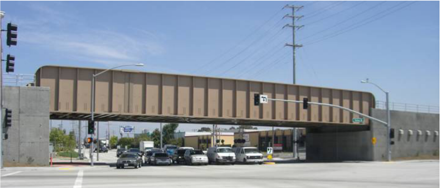
Sunset Ave 與Valley Blvd路口平交道分隔工程實景
