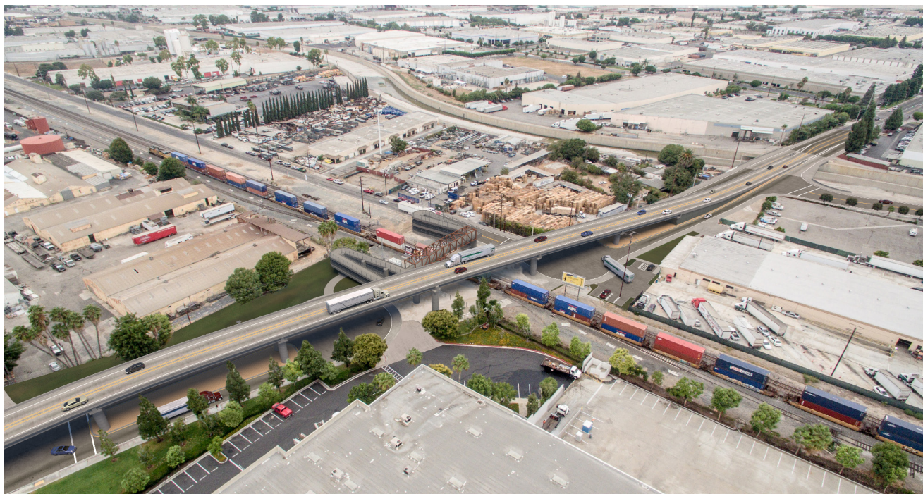
Representación aérea de la separación a nivel de Turnbull Canyon Road completada.
